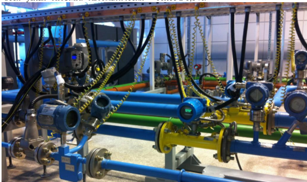
Рис.4. Примеры измерительных устройств в составе научно-испытательного стенда. На желтой вставке трубопровода расположен расходомер газа DYMETIC-1223M-T. Справа от него в трубопровод вмонтированы датчики давления и температуры.
